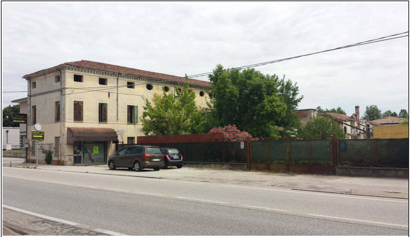
Vista sud - est
