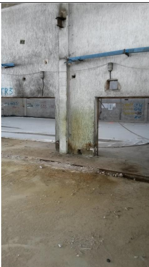
*Foto n.2 – Capannone cromatura interno – contaminazione delle murature (vista nord-sud)*
