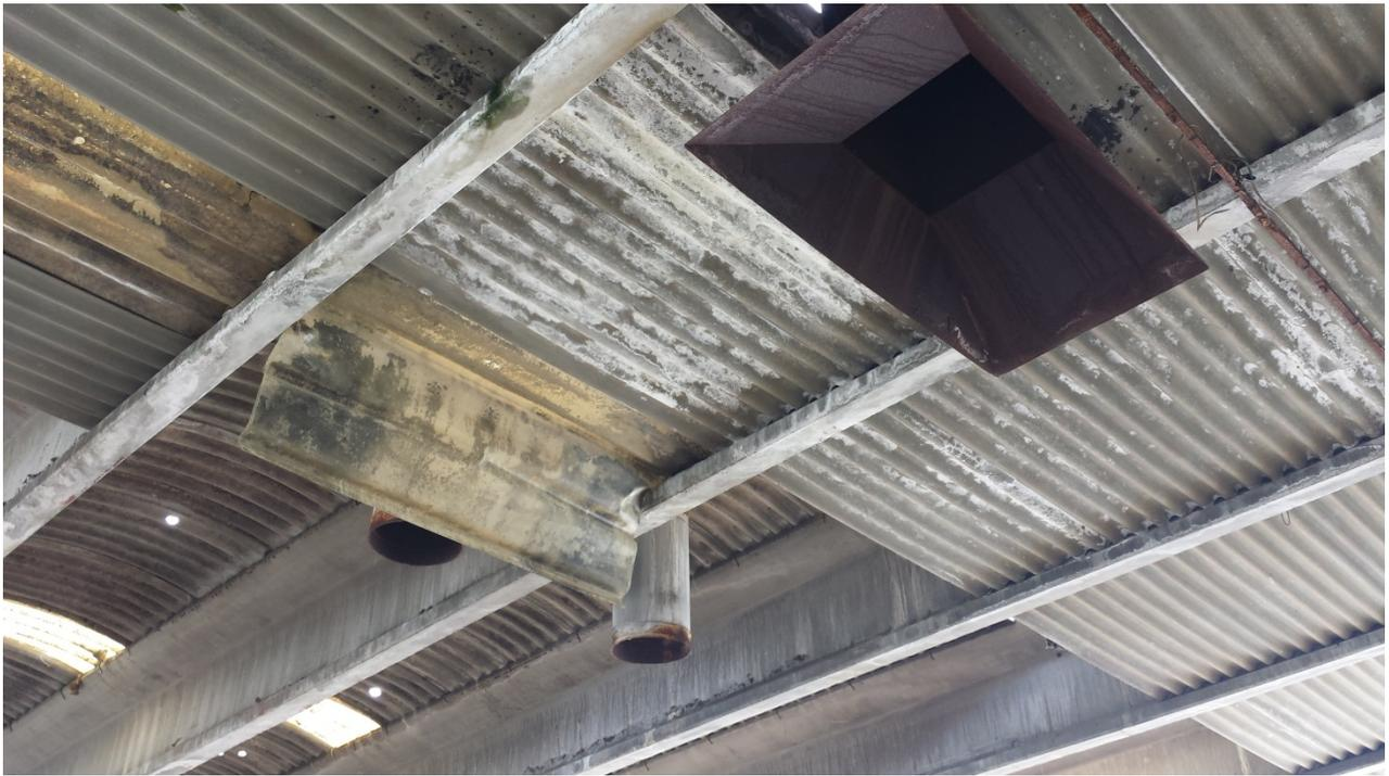
*Foto n.7 – Capannone cromatura doppio soffito in pannelli di cemento-amianto*
